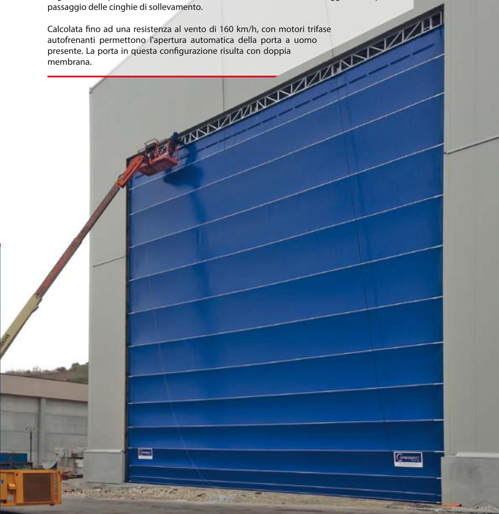
Le porta ad avvolgimento THUNDER è provvista di un sistema a tenuta laterale in materiale polimerico autolubrificante che permette l'auto-riparabilità e un maggiore isolamento termico garantito anche dal manto unico realizzato in tessuto poliestere biplasmato in ordito e trama di 1300 gr/mq.
